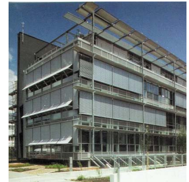
WAT building, Karlsruhe (D)
