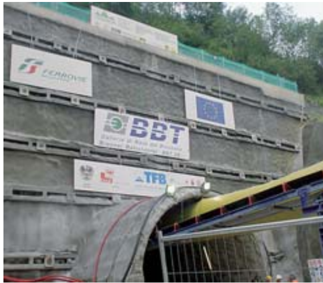
Galleria Il cantiere del cunicolo esplorativo ad Aica
