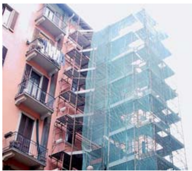
Ristrutturazione Cantiere edile: rallentano anche i rifacimenti
