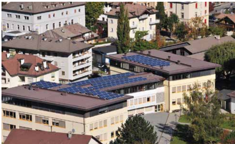
INSTALLAZIONE FOTOVOLTAICA DA 32 KWP PRESSO LA SCUOLA ELEMENTARE DI BRUNICO. GLI INTERVENTI DEL COMUNE A FAVORE DELLA SOSTENIBILITÀ SI PONGONO COME ESEMPIO PER LA COLLETTIVITÀ (FOTO MARTIN TINKHAUSER)
