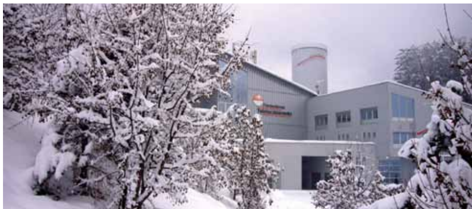
L'IMPIANTO DI TELERISCALDAMENTO, GRAZIE AD UNA RETE LUNGA 120 KM, FORNISCE CALORE AD OLTRE 2.000 UTENZE (FOTO MARTIN TINKHAUSER)
