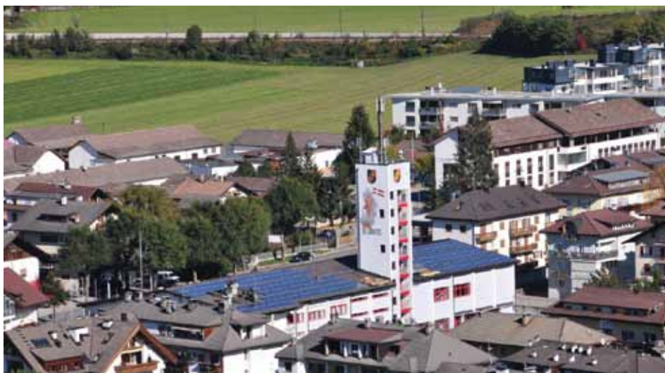
L'IMPIANTO FOTOVOLTAICO DA 64 KW DELLA CASERMA DEI VIGILI DEL FUOCO DI BRUNICO GARANTISCE L'AUTONOMIA ELETTRICA DELL'EDIFICIO (FOTO MARTIN TINKHAUSER)
