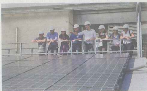
Die große Photovoltaik-Versuchsanlage am Bozner Flughafen ist ein „enertour“-Ziel.
