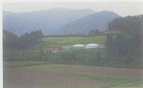
In St. Lorenzen zeigt „enertour“ die genossenschaftliche Nutzung einer Biogasanlage.
