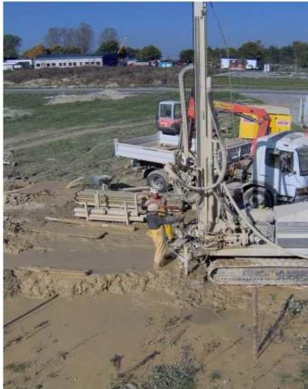
Einbau einer Erdwärmesonde
