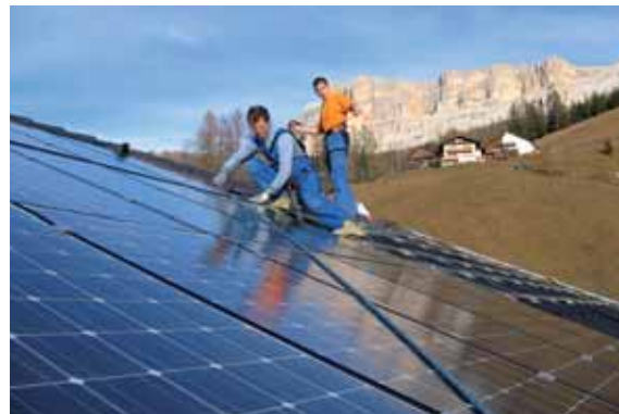
Montaggio di un impianto FV (fonte: PVEnergy)
