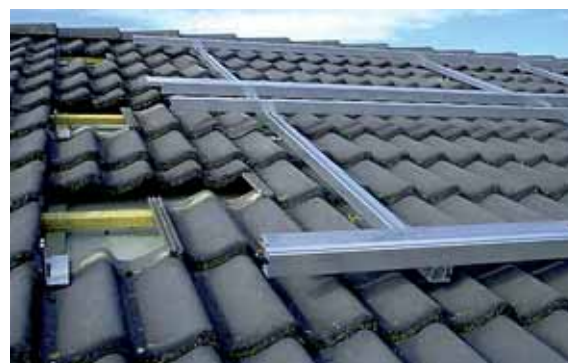
Supporto di montaggio di un impianto FV su tetto a tegole (fonte: www.rema-technik.de)
