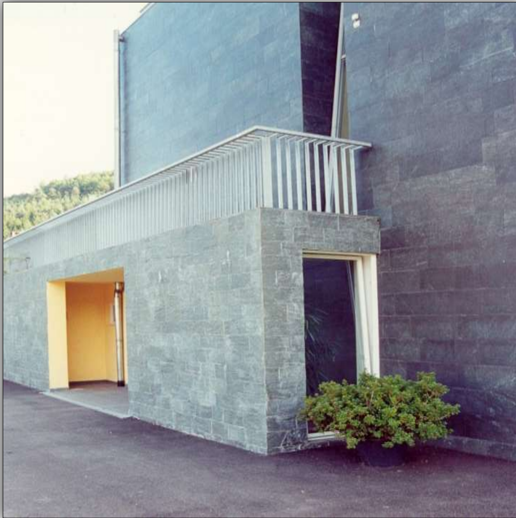
Fassade aus Serpentin
